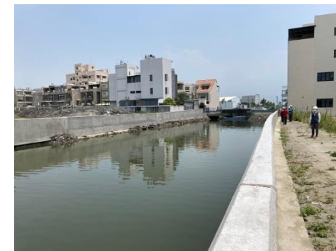
東港第一排水護岸改善工程
