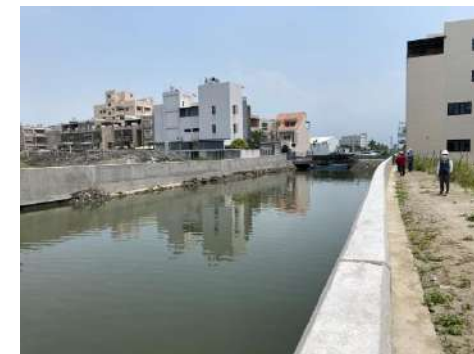
東港第一排水護岸改善工程
