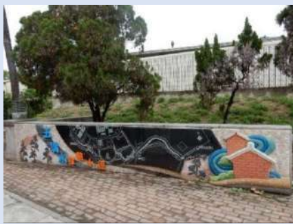
五溝水探險小徑完工照片
