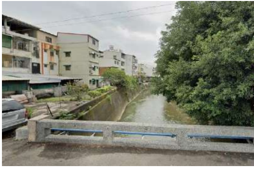
廬山橋至綠溪一號橋區段
