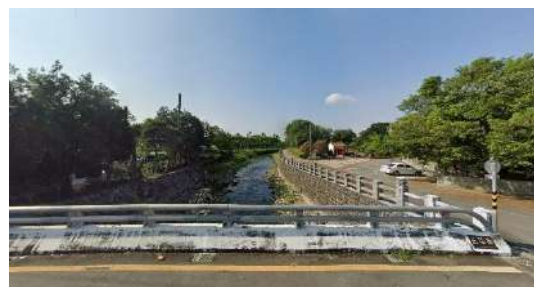
五福橋南段現況
