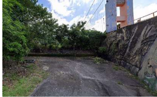
丹林吊橋周邊環境現況
