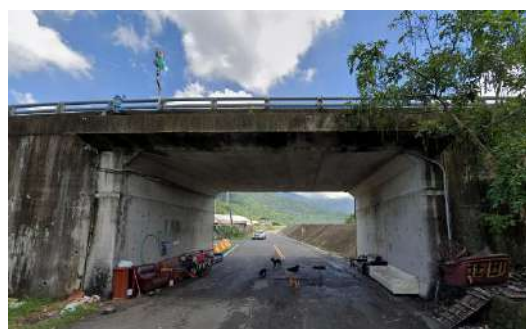
涵洞空間現況
