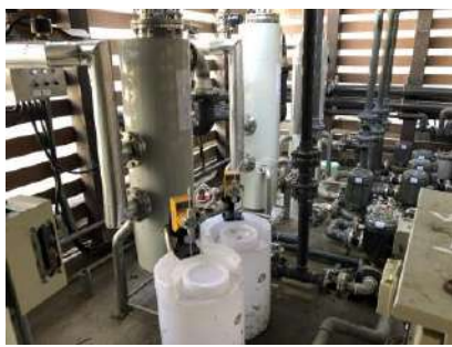
蒸氣式熱水加熱器示意圖
